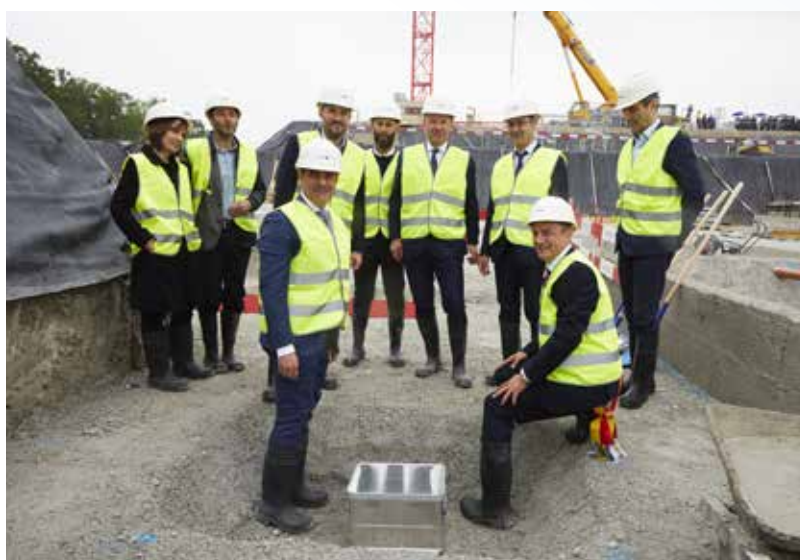
Pose de la première pierre de la pièce urbaine le 17 mai 2019 à Thônex.
