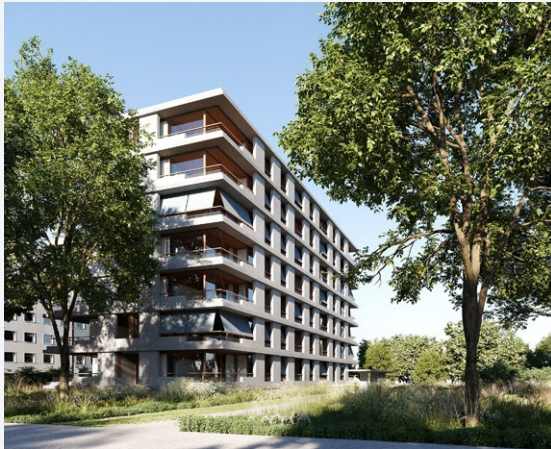
IMMEUBLE DE LOGEMENTS AMANDOLIER GENÈVE (GE)
